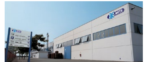
Bagnoli di Sopra (Padua)
