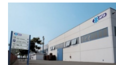
Bagnoli Druckbehälter, Wärmetauscher
